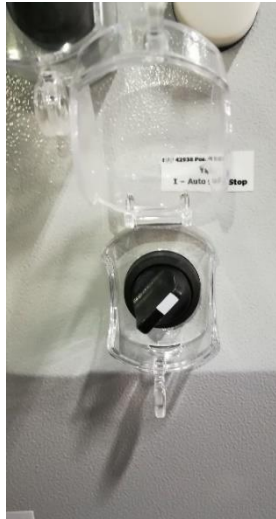
Se gira el selector a la derecha para dejar de alimentar al yaw
